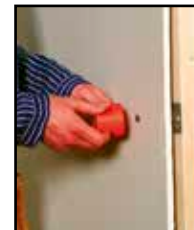
Finn innsatsen med HOLE IN ONE-søker 8:21 eller supersøker 2000, og marker midten.
