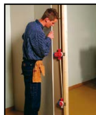
Montera gipsplattan/panelen.
