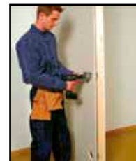
Bor hull med hull- bor. Plasser boret så langt ut som mulig.
